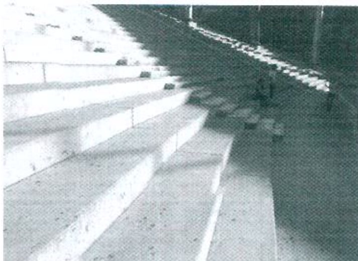
Foto N° 10: Escalones prefabricados de cemento que forman la galería.
